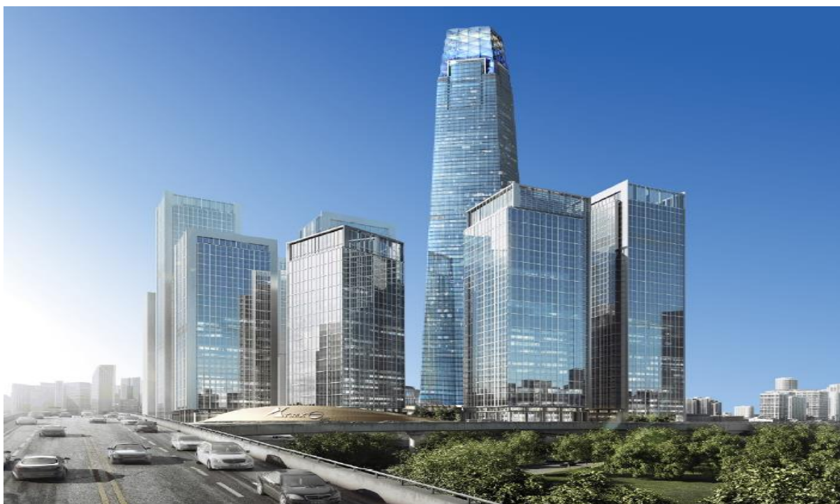
马来西亚吉隆坡标志塔（423 米，在建）
