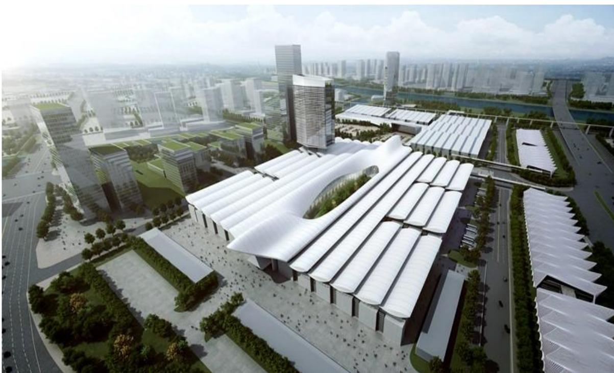
广东（潭洲）国际会展中心二期及配套项目（在建）
